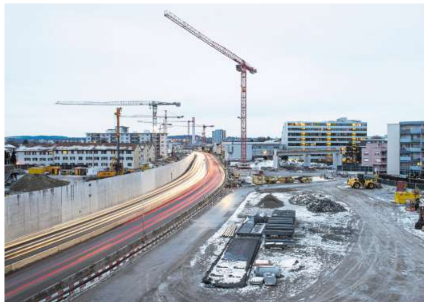
Baustelle in Zürich Schwamendingen.
