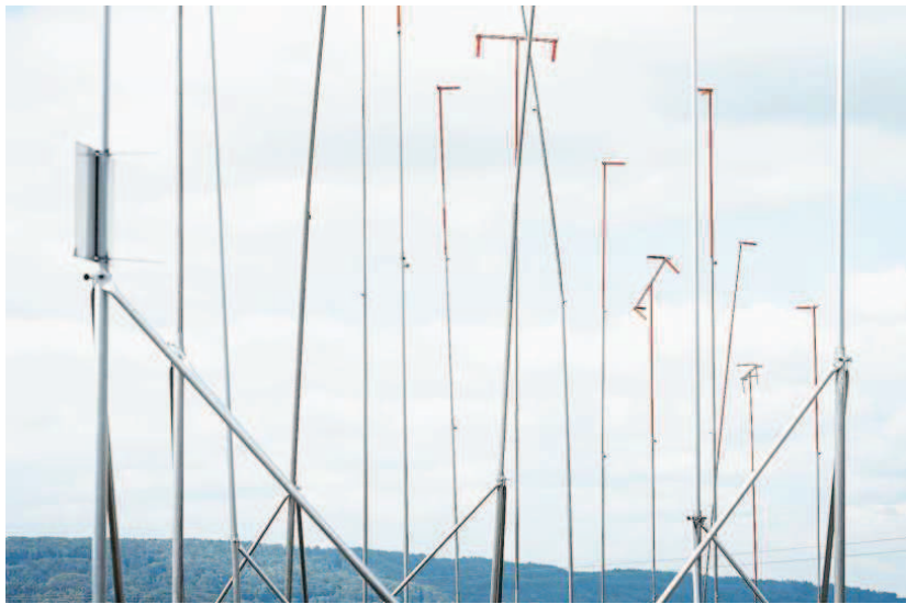
Wo heute Bauprofile in die Luft ragen, mussten häufig erst noch Gebäude abgerissen werden.
